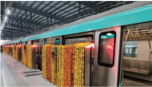
印度孟买地铁 3 号线
