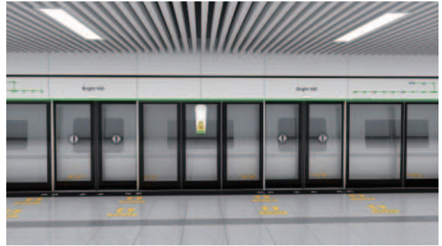
新加坡地铁跨岛线全高安全门项目效果图
